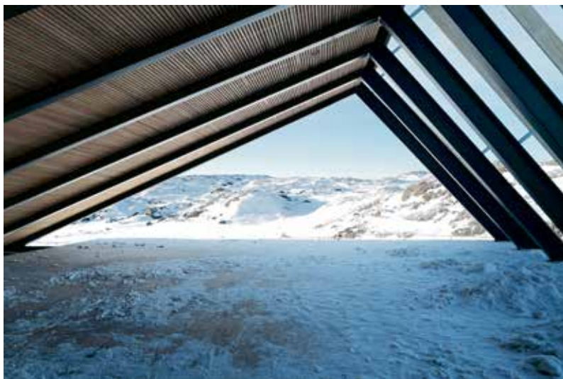
Bygningens bærende stålkonstruktion begynder i en trekant, der med bygningsforløbet gradvist ændrer sig til en rombe-form, for igen at ende ud i en trekant.
