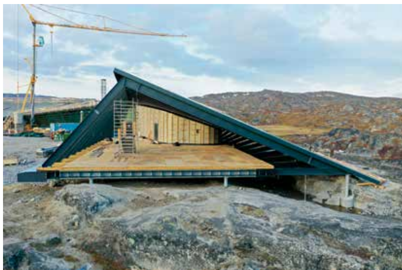
Isfjordscentret under opførelse.
