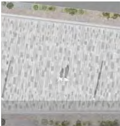
EKSEMPLER PÅ BELÆGNINGER
