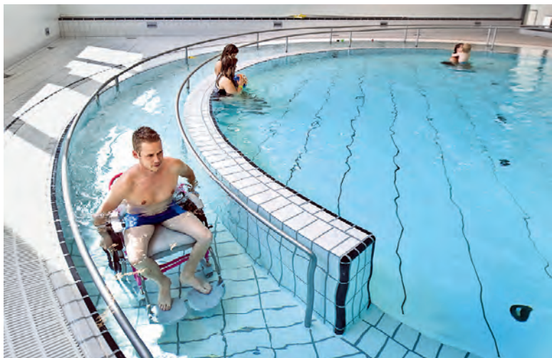
VANDHALLA ER VANDLAND FOR ALLE. KØRESTOLEN KAN VIA EN RAMPE KØRES HELT NED I VANDET.
