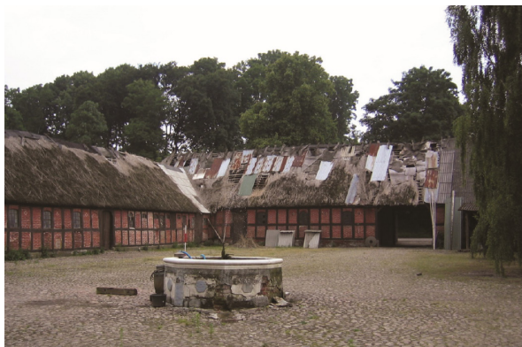
Før: Skjødthgården var helt ubeboelig før den gennemgribende restaurering.
