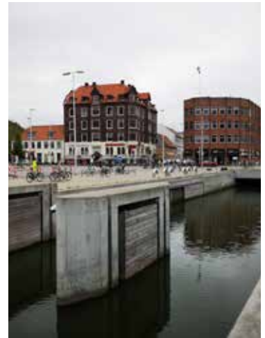
Slusen i Aarhus Å lige inden mødet med havnebassinet. Ved siden af, er der etableret underjordisk overløbsbassin. Foto: Nikolaj Knudsen.
